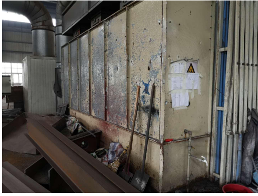
喷漆房水帘室（保留）
