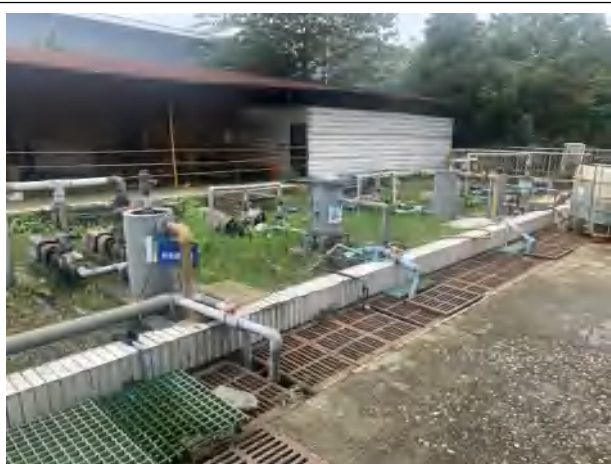
污水站-地下污水池体、管线
