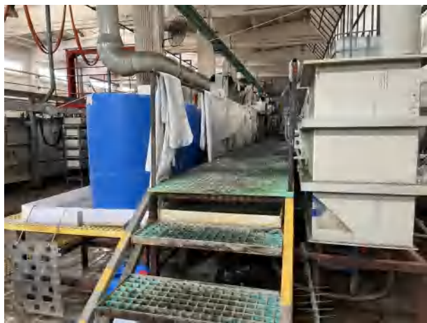
2#厂房-挂镀镍生产线（地上槽体/生产线）
