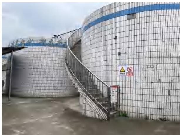
污水站-接地污水池体
