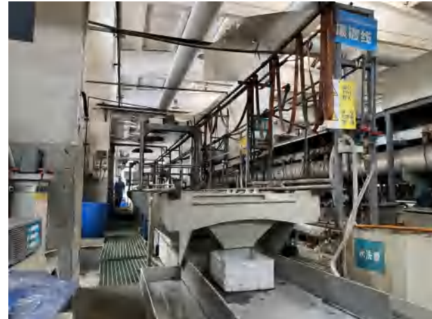
2#厂房-滚镀镍生产线（地上槽体/生产线）
