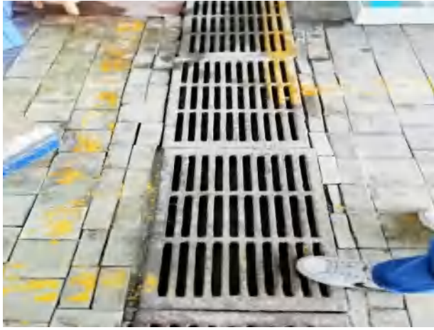
2#厂房-车间内应急收集沟
