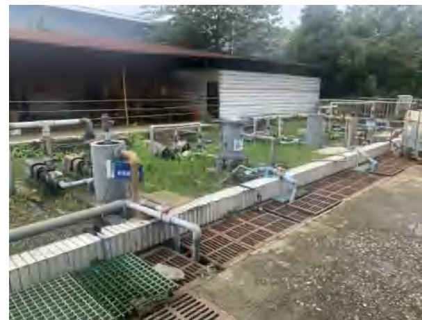
污水站-地下污水池体、管线
