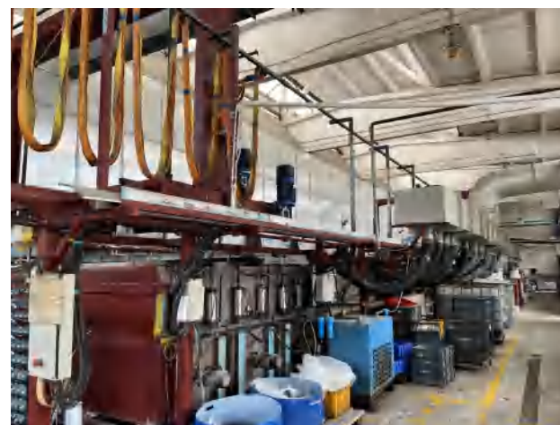
2#厂房-挂镀锌生产线（地上槽体/生产线）
