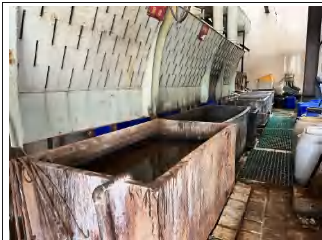
2#厂房-酸洗（地上槽体/生产线）
