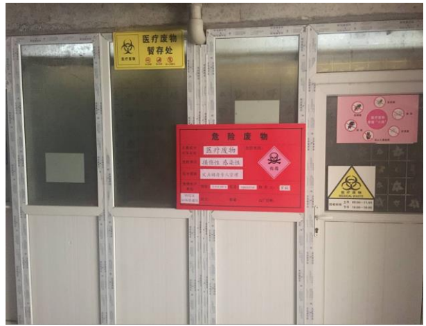
医疗废物暂存间（外部）
