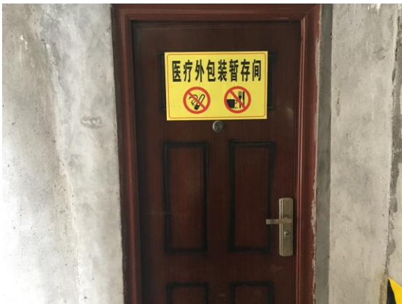
医疗外包装暂存间
